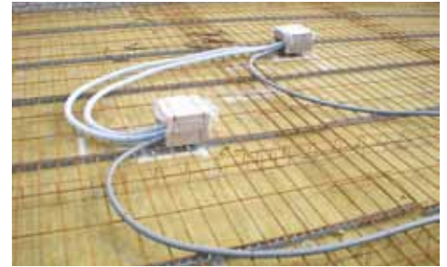
La préparation du chantier est simple et rapide.
