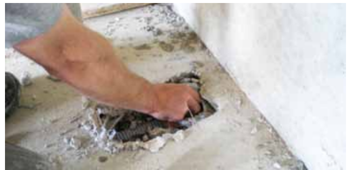
Le retrait de la réservation se fait facilement et rapidement à la main. Le nid d'abeilles est fabriqué avec du carton recyclé et est à évacuer avec les cartons à recycler (chantier Haute Qualité Environnementale).
