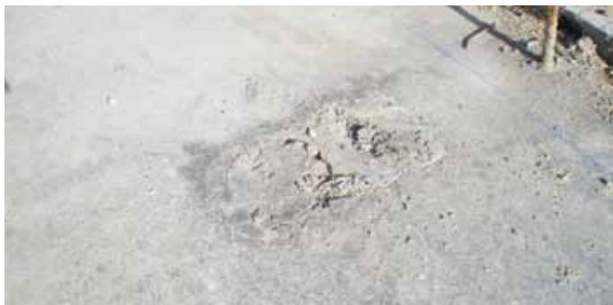
Suite au coulage et séchage de la dalle, les réservations sont très clairement repérables. Rien n'a gêné le tirage du béton ni le passage de l'hélicoptère car les réservations sont sous le niveau de la dalle.
